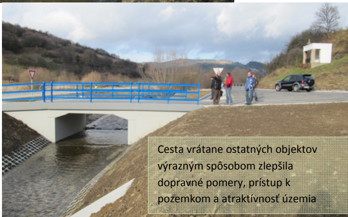
Pri výstavbe poľnej cesty medzi Vyšnými a Nižnými Ružbachmi bolo potrebné vybudovať mostný objekt.
